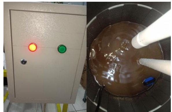
Gambar 10. Indikator Motor Kondisi OFF Sumber : Dokumen pribadi
